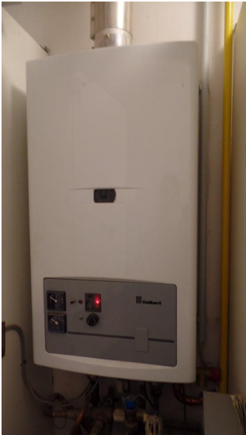
Bild 14: Heiztherme Fabr. Vaillant, Bj. 1997
