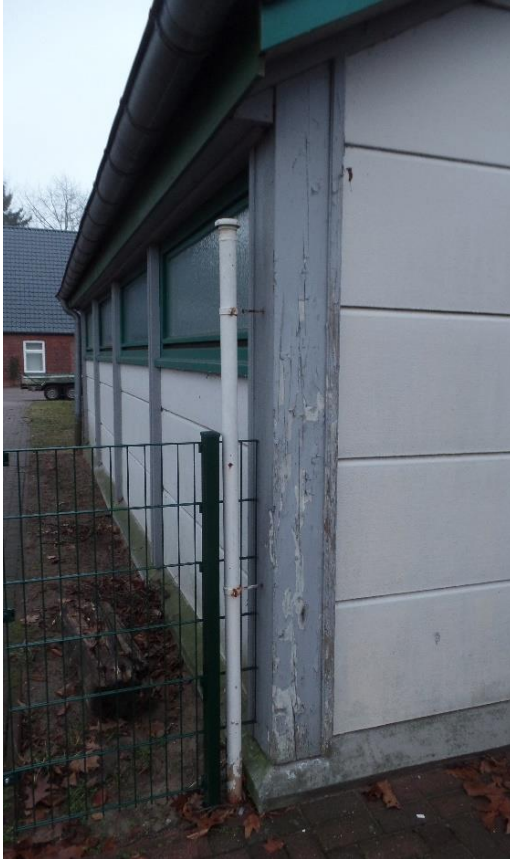
Bild 6: Holzständerwerk mit Beschädigungen
