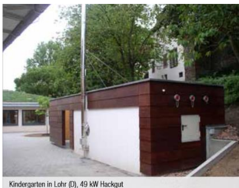
Bild 12: Heizzentrale eines Kindergartens
