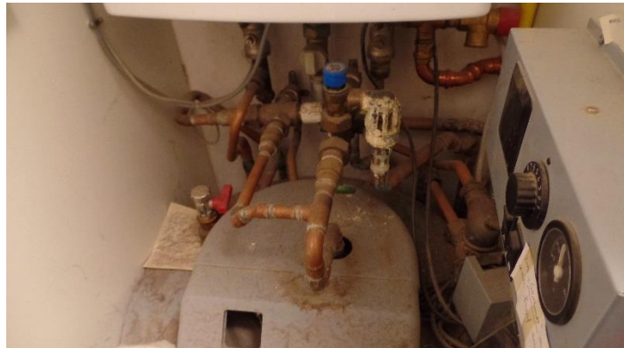
Bild 15: Warmwasserbereiter mit Undichtigkeiten
