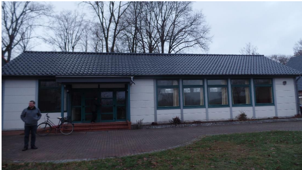
Bild 2: Dorfgemeinschaftshaus Klempau – Frontansicht
