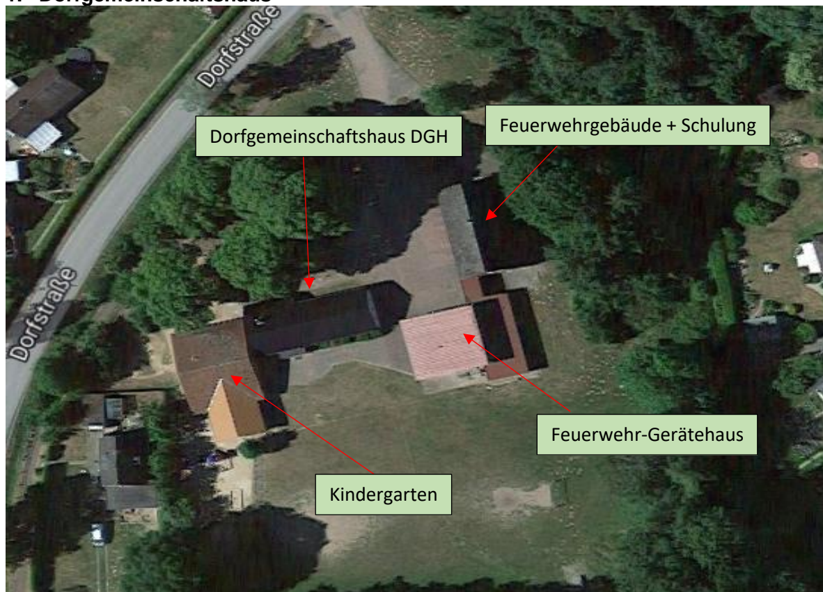
Bild 1: Gemeinde Klempau – öffentliche Gebäude
