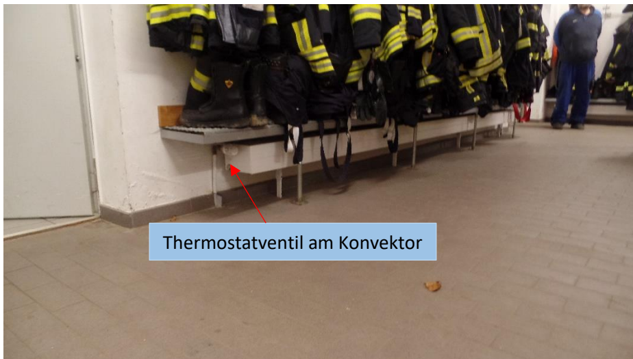
Bild 17: Konvektor unterhalb der Umkleidebank
