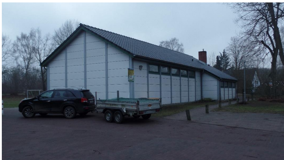
Bild 3: Dorfgemeinschaftshaus Klempau - Giebel- und rückwärtige Ansicht
