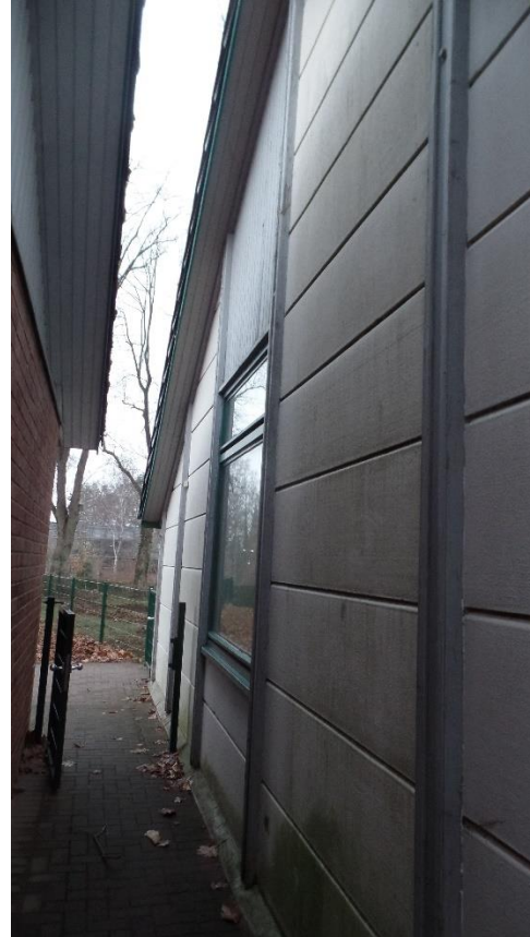
Bild 7: Betonelemente mit Moosbildung
